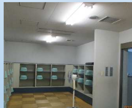
扇風機等による 脱衣所の換気
