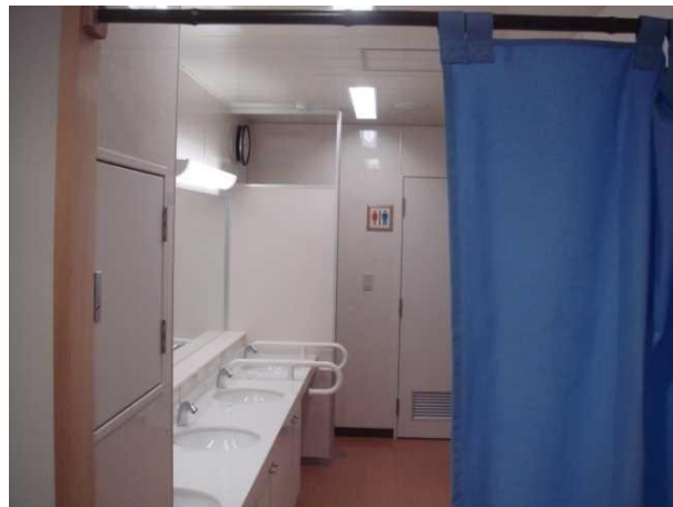
洗面台4個、トイレもあります。
